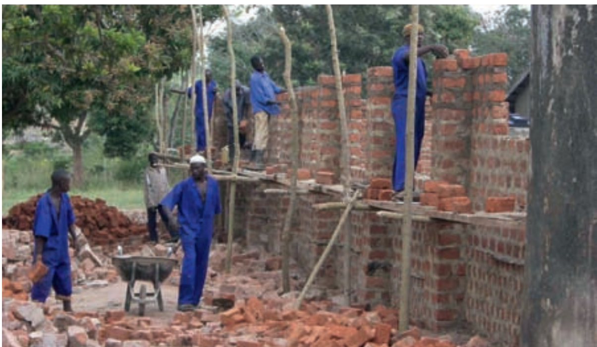
Bauarbeiter in einer südafrikanischen Provinz
